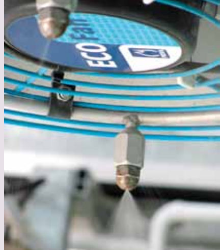
Fot. 2. Ciśnieniowy system zamgławiania
